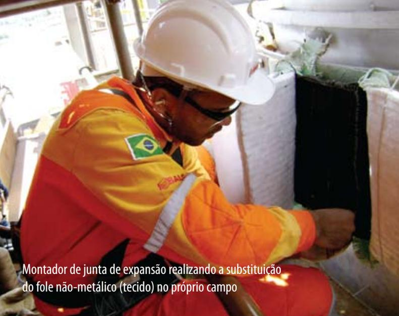
Montador de junta de expansão realizando a substituição do fole não-metálico (tecido) no próprio campo
